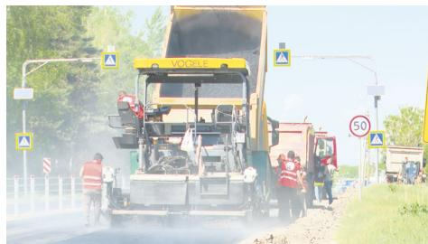
едва ли не на всём многокилометровом участке автодороги. Подрядился их выполнить ПК «Воскресенский» Мосавтодора. В понедельник мы застали бригаду воскресенских дорожников за укладкой асфальтобетонной смеси на километровом участке 106.306 – 107.306 автодороги М-5 «Урал» – Коломна – М-5 «Урал» в Щурове. Здесь вовсю работали асфальтоукладочный комплекс и вспомогательная техника.
